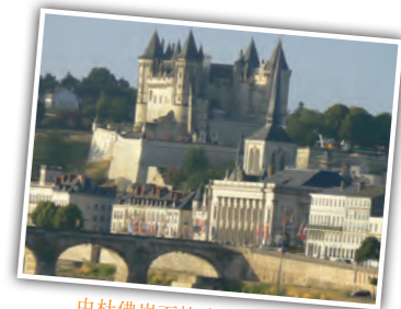
由杜佛岩而构成的建筑物
